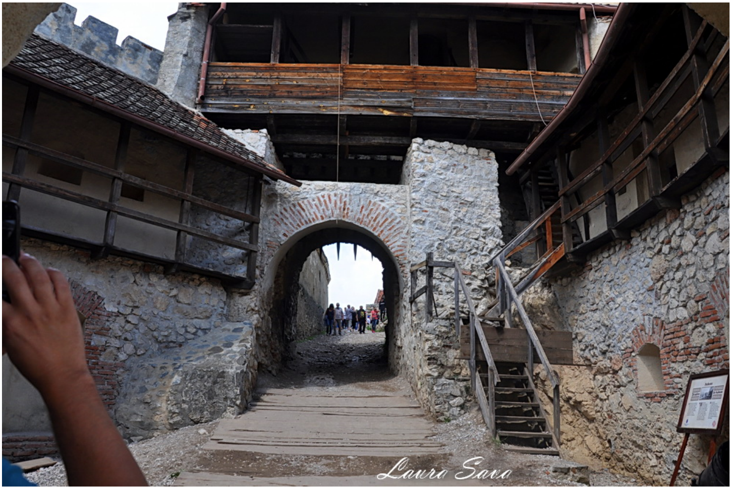
Ruine, ziduri interioare:
